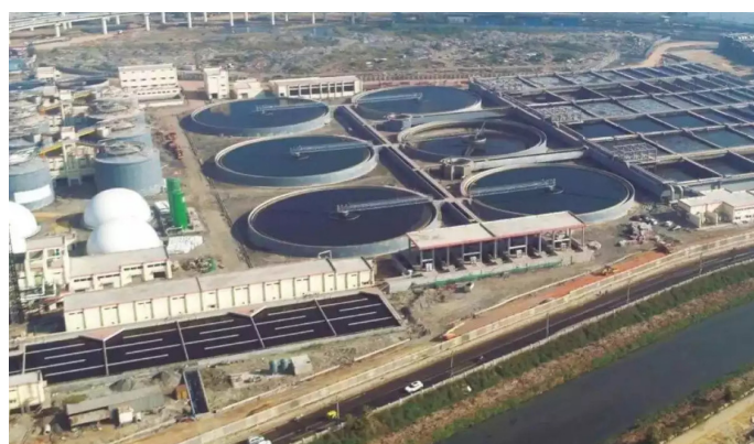
Очистные сооружения в Дели
