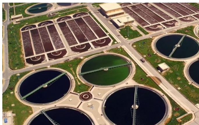
Очистные сооружения Тегерана
